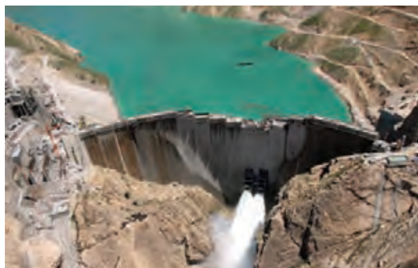
شکل ۷- سد کارون (۴) - خوزستان
