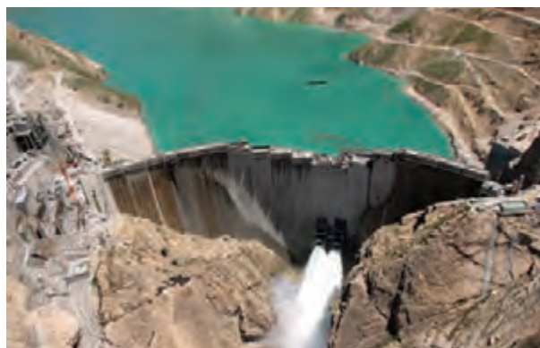
شکل ۷- سد کارون (۴) - خوزستان
