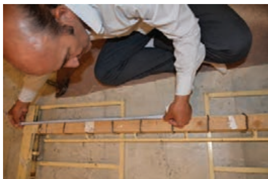
شکل ۱۸-۵ - نشانه‌گذاری بر روی چوب پایین‌کشی
