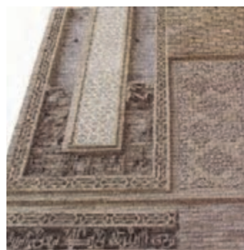
شکل ۲-۷۰- کرمان، قواره‌بری آجری مسجد ملک
