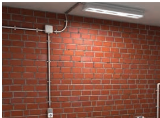
شکل ۳۲-۳- نمونه‌هایی از سیم‌کشی روکار
