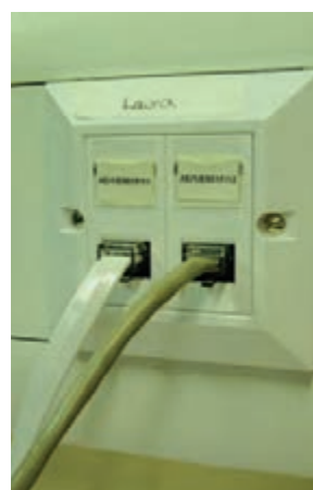
شکل ۲۶-۳- تصویر ظاهری و شمای فنی پریز تلفن
