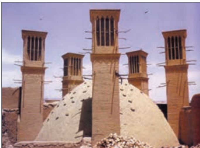
تصویر شماره ۵۰-۲- آب انبار و بادگیرهایش
