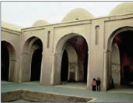
ج - دید داخل حیاط مسجد جامع فهرج
