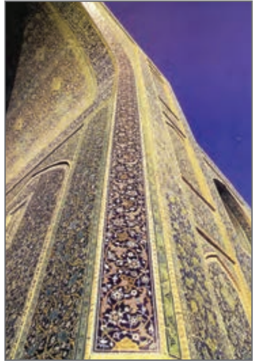
تصویر شماره ۵-۱۰ - ایوان شمالی مسجد امام اصفهان، کاشی‌کاری پخی دیوار از نوع معرق و متفاوت با دو بدنه مجاورش می‌باشد.
