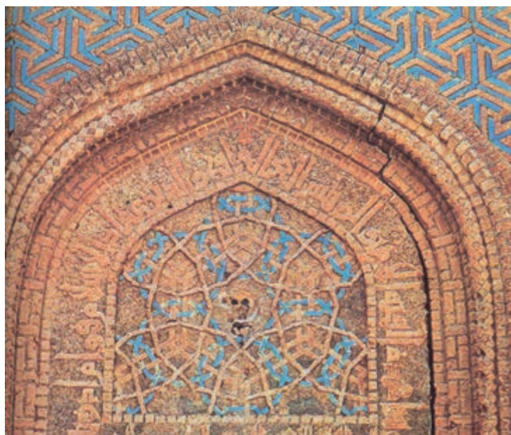
▲ شکل ۹-۶- گنبد کبود، مراغه، آذربایجان شرقی
