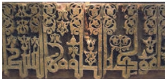
شکل ۶۱-۲- خراسان، آجر تراش، مدرسه غیاثیه خرگرد
