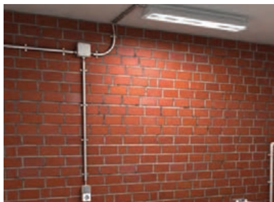
شکل ۳۲-۳- نمونه‌هایی از سیم‌کشی روکار
