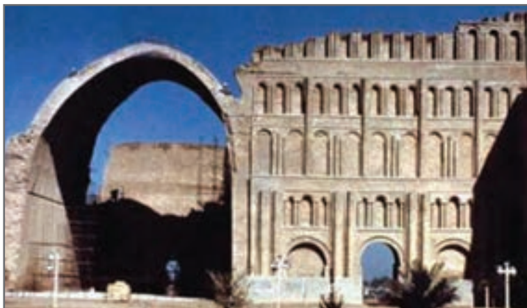
تصویر شماره ۲۸-۲- تاق کسری یا ایوان مدائن، نمونه بارز تاق آهنگ در دوران پیش از اسلام
