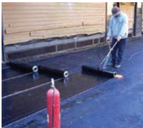
شکل ۱۳-۱- عایق کاری رطوبتی با استفاده از عایق آماده
