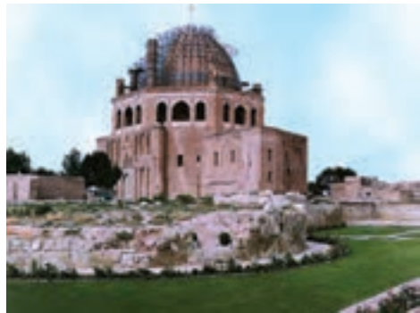
شکل ۳-۶- سلطانیه (بزرگ‌ترین گنبد آجری جهان) با ۲۶ قطر و ۵۱ متر ارتفاع از رأس آن تا سطح زمین
