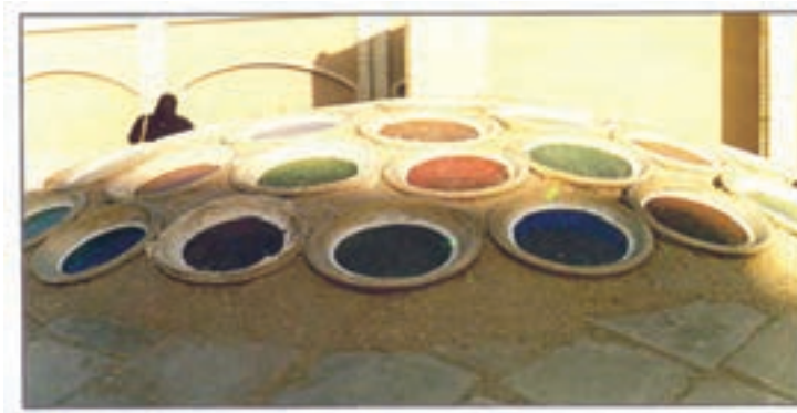
شکل ۲-۱۲- استفاده از گلجام در بازسازی سقف حمام
