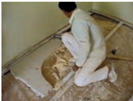
شکل ۸-۴- نحوه‌ی اجرای قوس گچی روی زمین به کمک رابیتس (چپ) و نصب آن در محل (تصویر راست)
