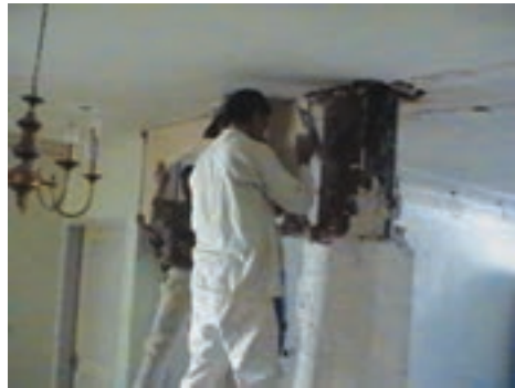
شکل ۸-۴- نحوه‌ی اجرای قوس گچی روی زمین به کمک رابیتس (چپ) و نصب آن در محل (تصویر راست)
