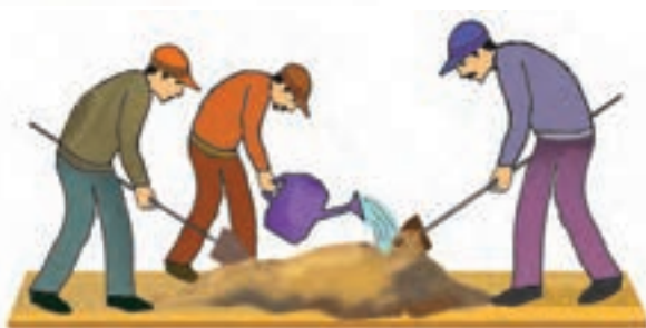
شکل ۳-۷- سرن‌کردن ماسه و مخلوط کردن ملات
